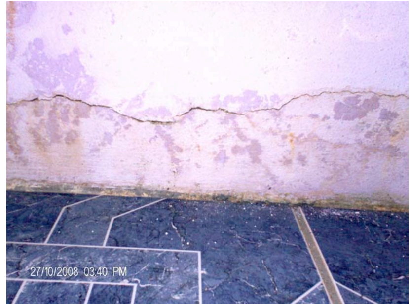
Figura 5d Tipo 4 Rajadura Horizontal
