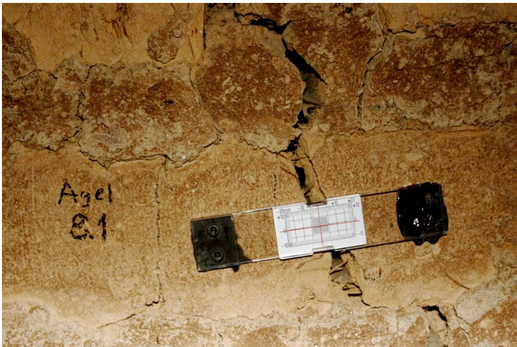
Figura 6b Calibrador de Rajadura
