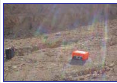
Figura 8. Equipo DR40-50 (EENETEC) utilizado para medir aceleraciones inducidas por las detonaciones de la mina subterránea.
