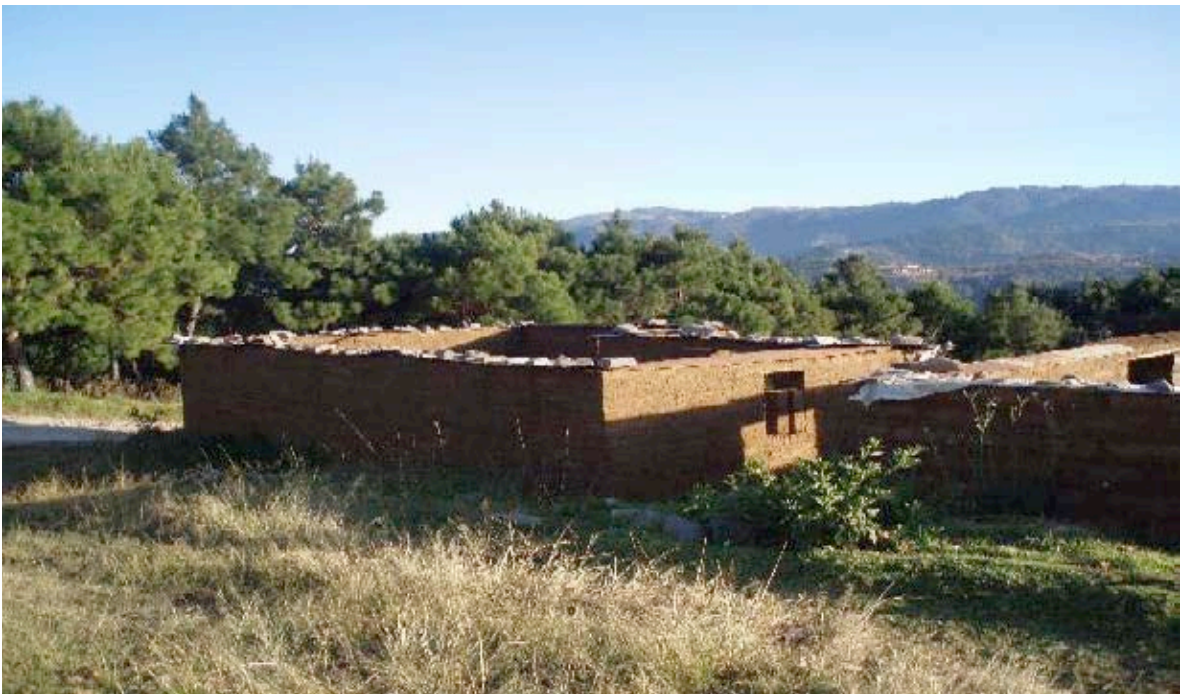
Foto No. 18 y 19: Secado de paredes.
