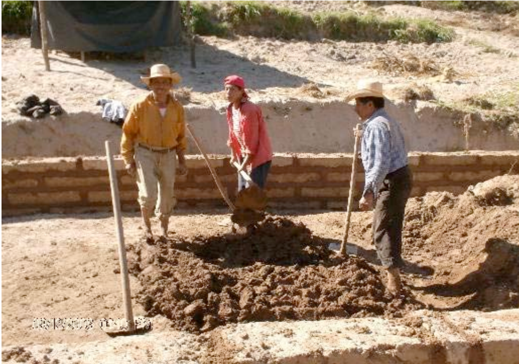
Foto No. 12: Preparación de la mezcla para el pegado de adobe.
