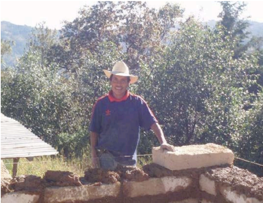
Foto No.13: Pegado de adobe.
