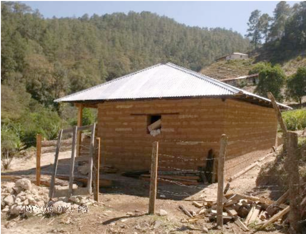
Foto No. 17: Tabla colocada en la parte de arriba de la ventana para sostener las filas de adobe que se encuentran por encima de la misma.
