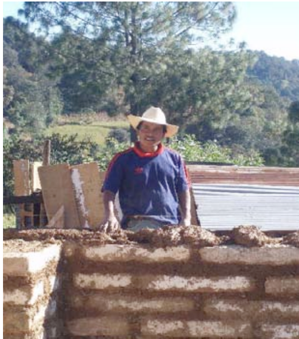
Foto No. 16: El hilo horizontal arriba de la mezcla, muestra el nivel a utilizar en las filas de adobe a pegar.
