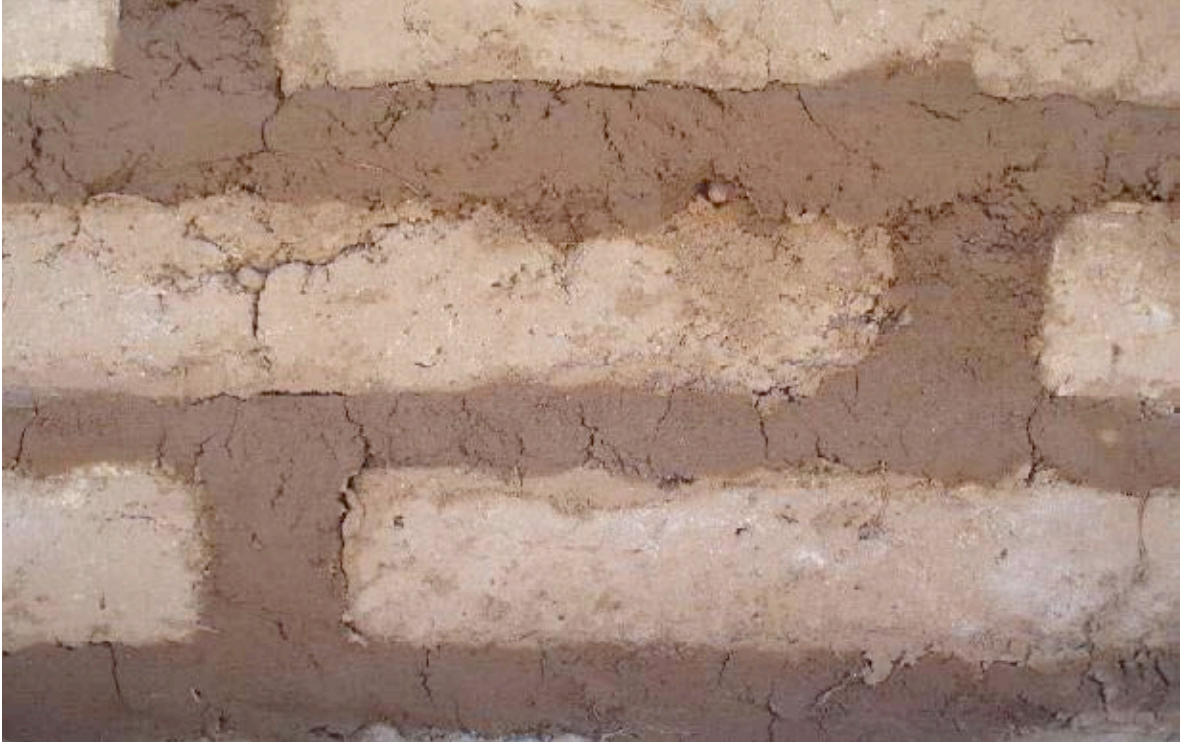
Foto No. 14: Forma intercalada de colocar los adobes.
