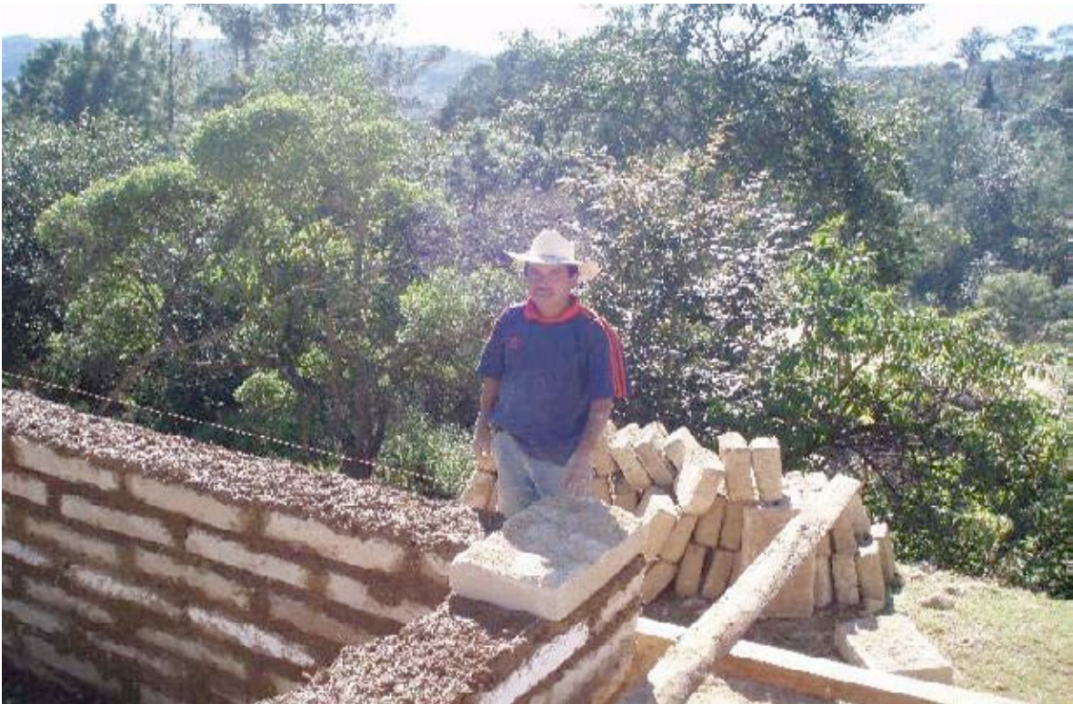
Foto No. 15: Colocación de la mezcla para el pegado de adobe.
