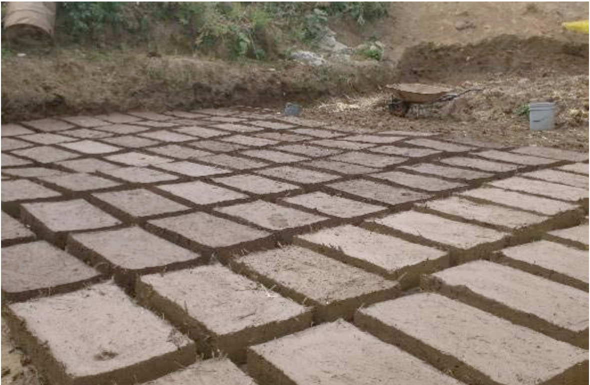
Foto No. 8: Adobes después de haber quitado la madera.
