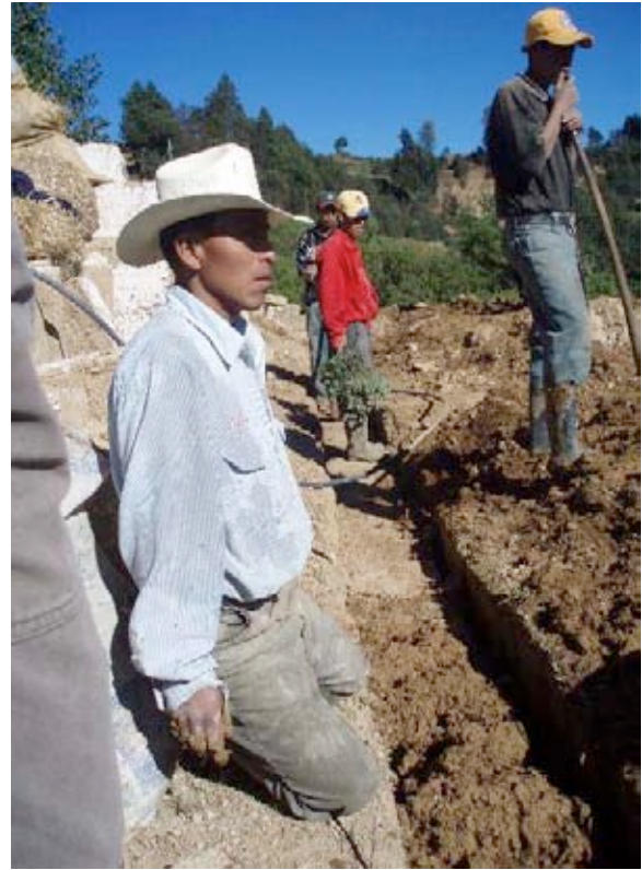
Fotos No. 10 y 11: Colocación del material para formar el cimientto.
