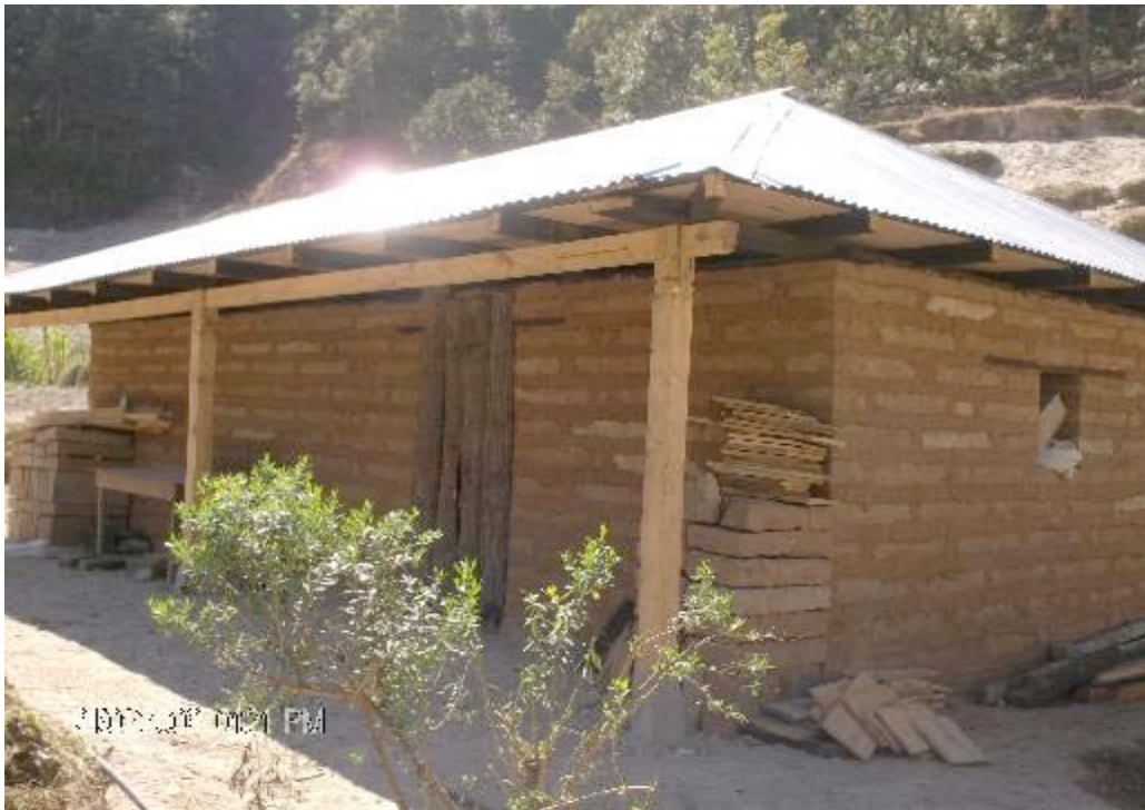
Foto No. 20: Casa con techo de lámina de zinc.
