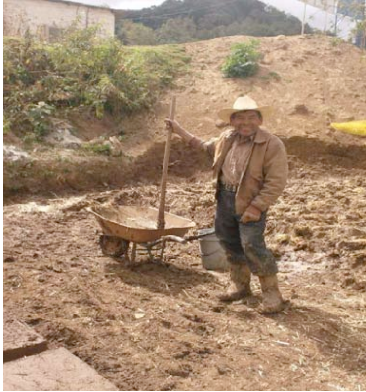
Foto No. 5: Preparación de la mezcla.
